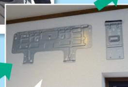
エアコンと換気ユニットの取付板を設置
