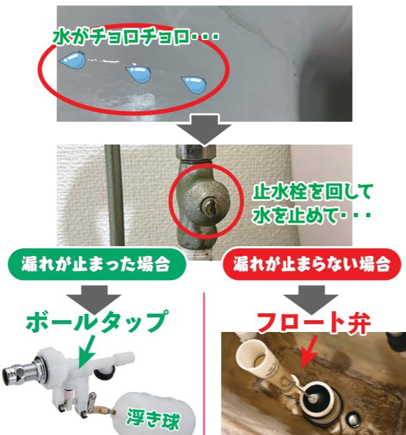
止水栓を止めて水漏れが止まれば、ボールタップと言う部品が壊れているか、浮き球の調整不足です。部品交換か浮き球調整をすれば直ります! ※補足・まとめへ続く
